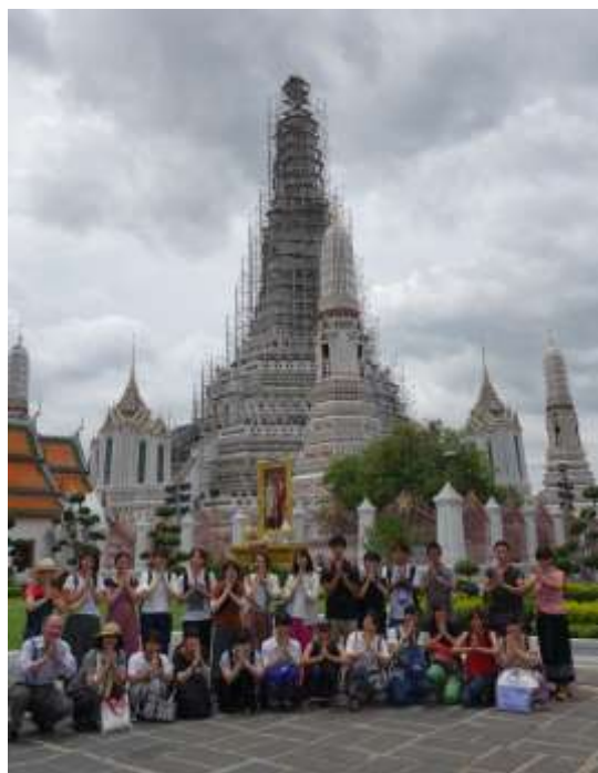
写真 37. ワット・アルン 修復中の仏塔
